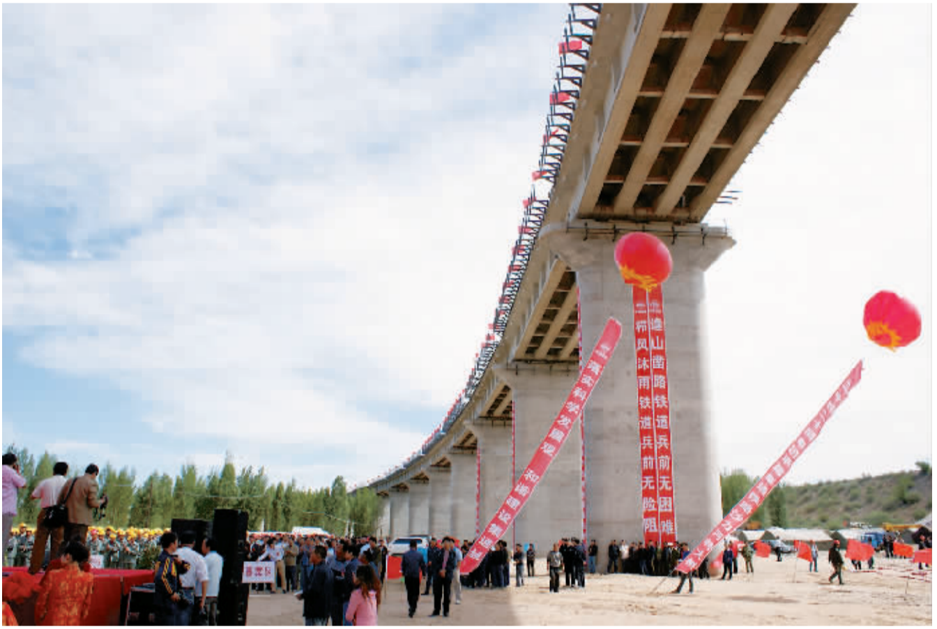
6月10日,集通铁路沙力河特大桥竣工庆典在巴林左旗举行。沙力河特大桥是集通(集团)公司铁路上第一座23孔—32米双线桥。
